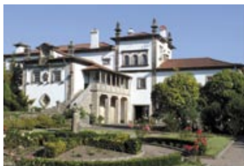
QUINTA DO CONVENTO DE VAL DE PEREIRAS Ponte de Lima · Portugal
